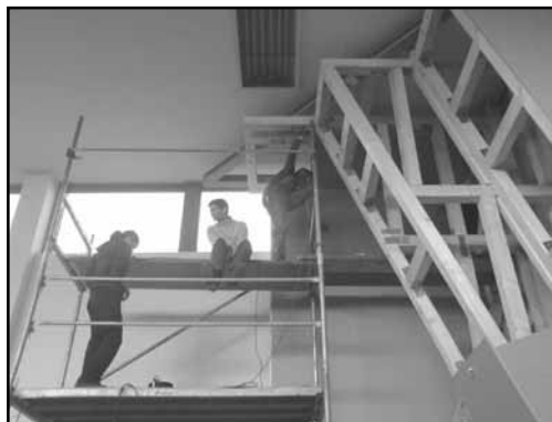
Der Überhang im Rohbau
